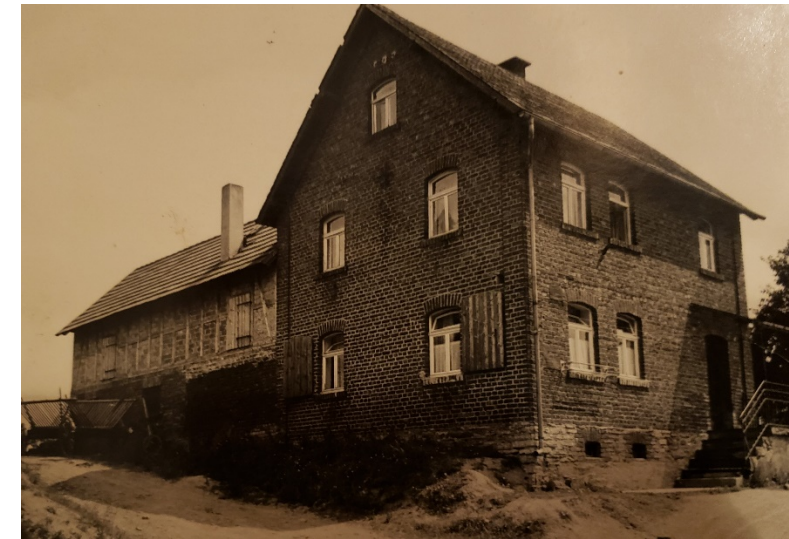
Nr. 84, Mornshausen an der Salzböde, Biedenkopf, Germany Hauptstraße 84, 35075 Gladenbach-Mornshausen, Germany
